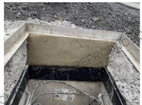
Masque à l'intérieur d'une chambre Télécom
