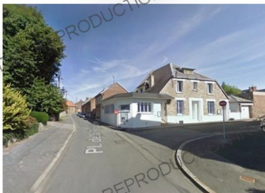
Bas de la rue du péage, Nesle Google Street View – Septembre 2010
