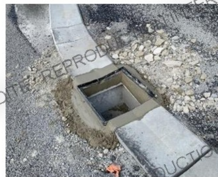
Scellement du support d'une grille de voirie
